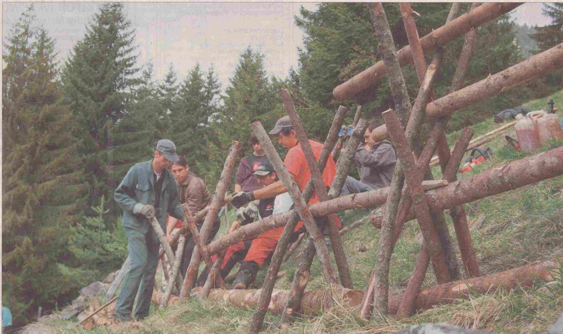
Die ersten Meter: Zu Beginn leistet Kursleiter Andreas Bosshard (links) noch Hilfestellung beim Bau des Schärzauns. (Bild: Leo Coray)
